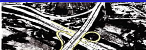
Création échangeur A502/A52 - Sortie de la A52 venant d'Aix vers la RD8n via la A502 - Sortie de la A502 sur la A52 vers Toulon en venant d'Aubagne/Gémenos via la RD8n
